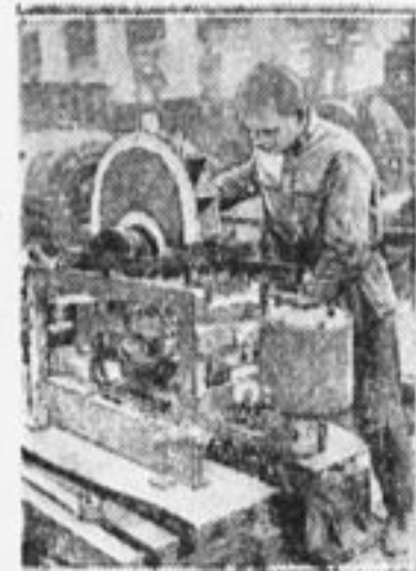
Новый усовершенствованный станок на электростанции в Харькове.
